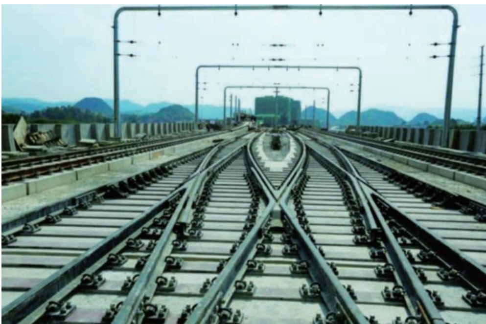
完成铺轨的轨道交通1号线观山湖段
